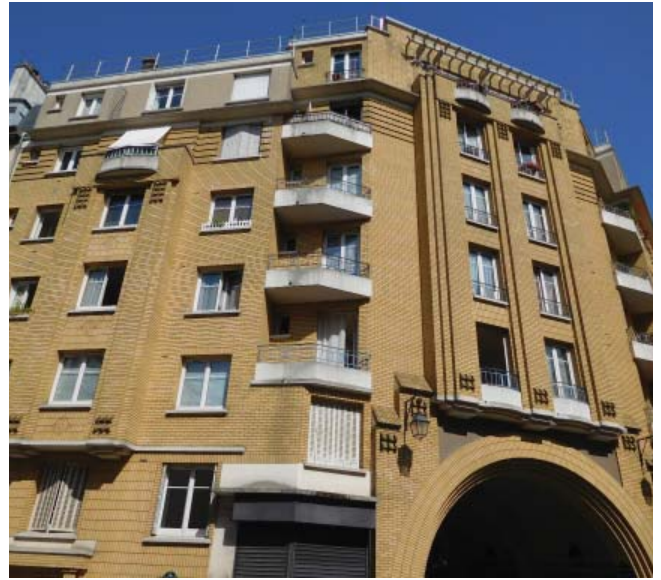
Façade arrière de la partie 1934 (brique), à droite la partie 17ème
