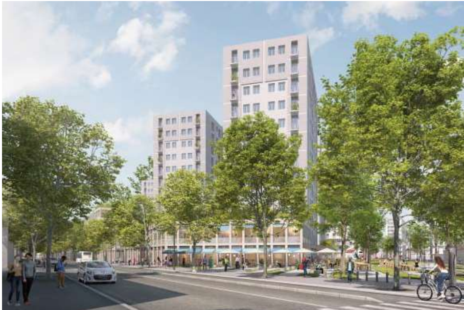
Vue de l'angle avec l'avenue de la République
