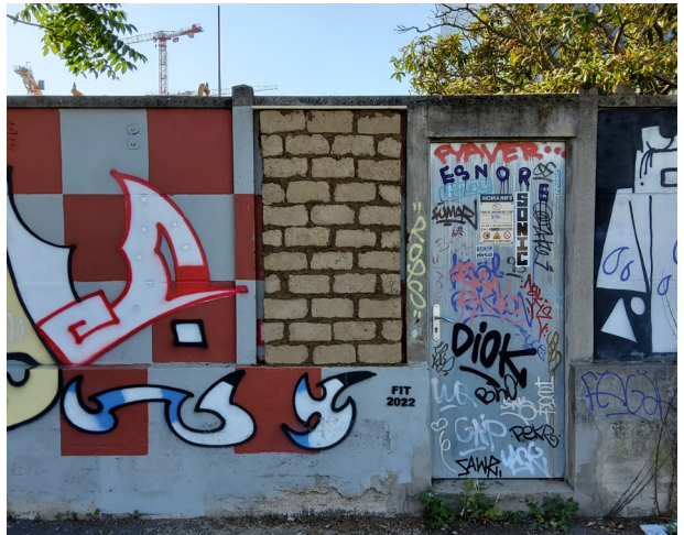
Building with Earth: adobe brick wall / Construire avec la terre: mur en briques d'adobe | Ivry-sur-Seine
