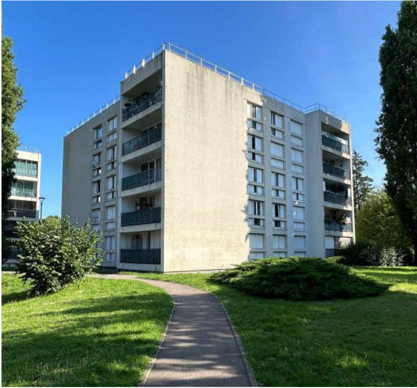
Façades existantes de l'un des plots de la résidence
