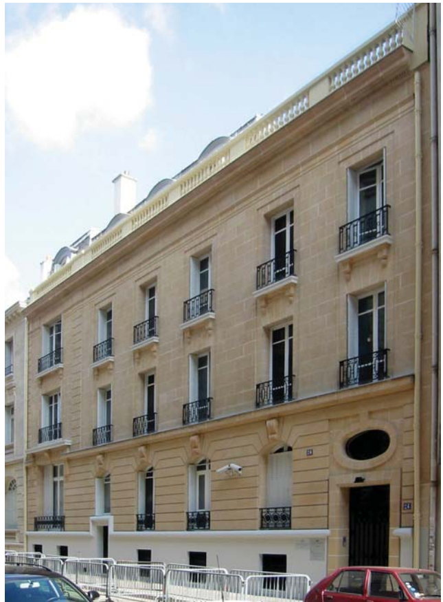
N°24, ravalement de la façade sur rue
