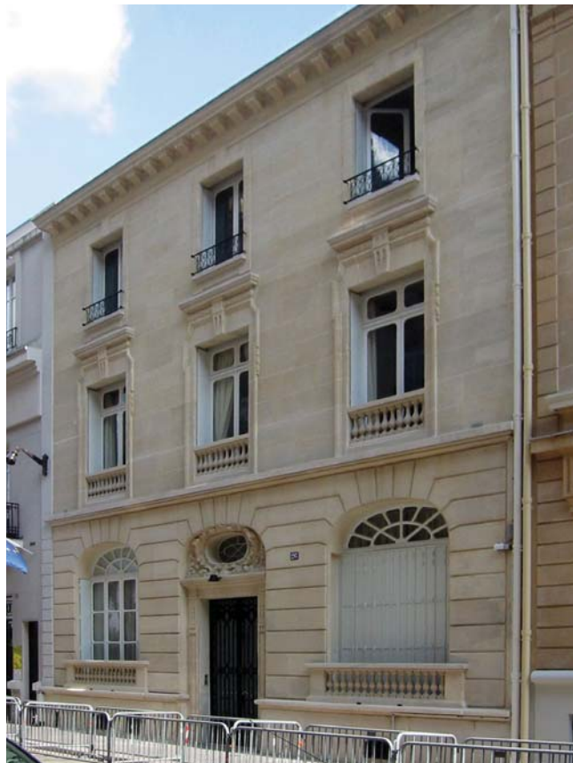
N°26, ravalement de la façade sur rue
