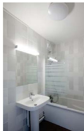
Refection des salles de bain
