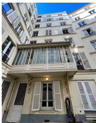
Façades sur cour
