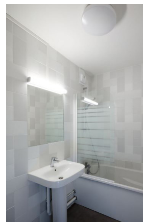
Refection des salles de bain
