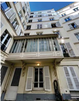
Façades sur cour
