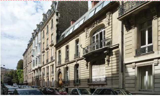
Façade rue Goethe
