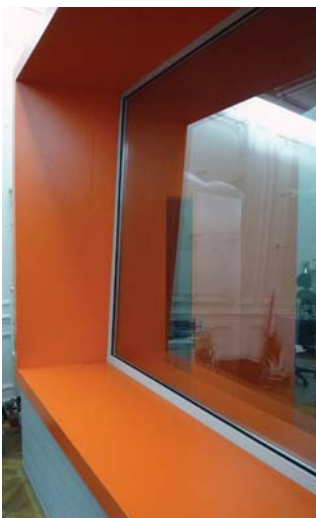
Séparation vitrée acoustique
